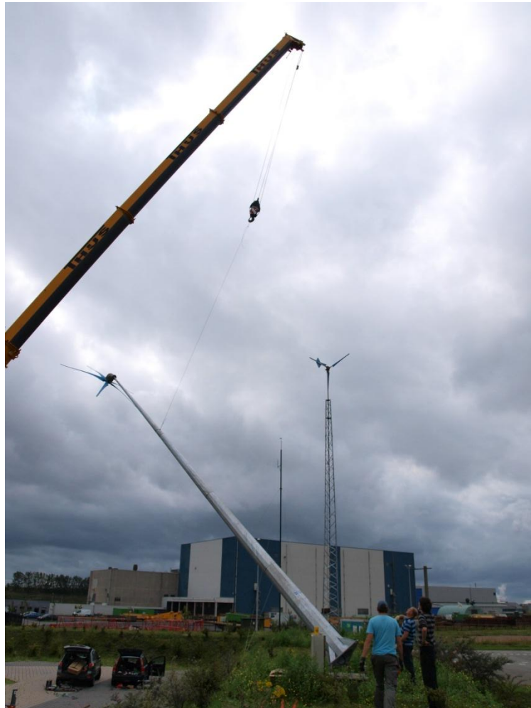
Figuur 14: Montage van een turbine met kantelbare buismast
